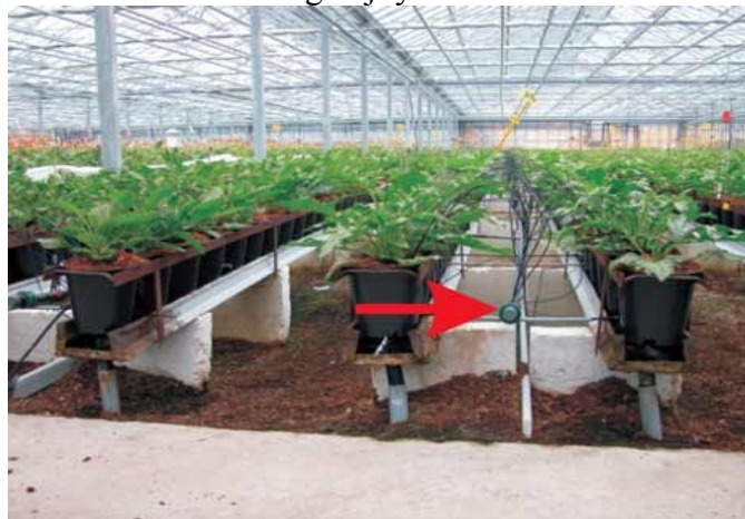
Zdjęcie statywów do uprawy Gerbery w doniczkach z systemem kapilar, rynnami i rurami grzejnymi.
